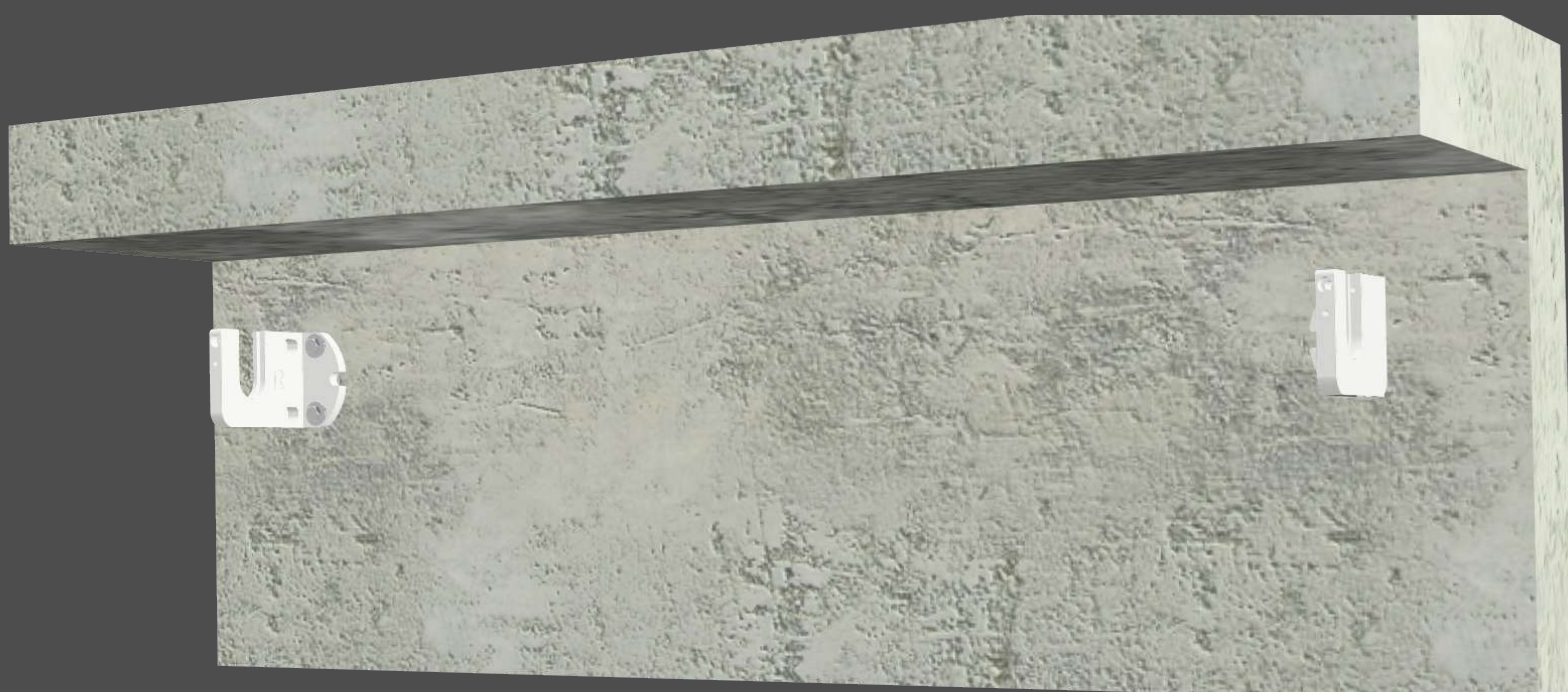
Colocar los soportes a nivel como mínimo a una distancia de 7cm de la losa.
